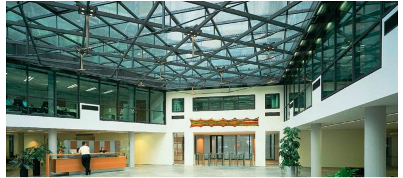
由克劳泽公司(Krause Company)建造的美茵茨西德地产银行(Westdeutsche Immobilienbank)的G30防火屋顶采用的就是肖特的PYRAN® S特种玻管。
